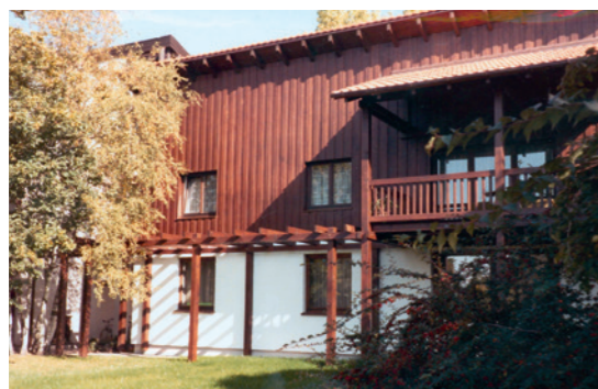
Anbau in dem die Wohnung für den Hausmeister untergebracht war von 1984.
