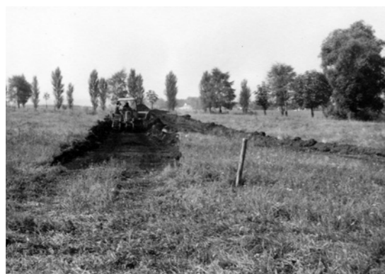
Beginn der Aushubarbeiten für den Rathaus-Neubau im Herbst 1964 zwischen der heutigen Poststraße und Ringpromenade in Puchheim-Bahnhof.
