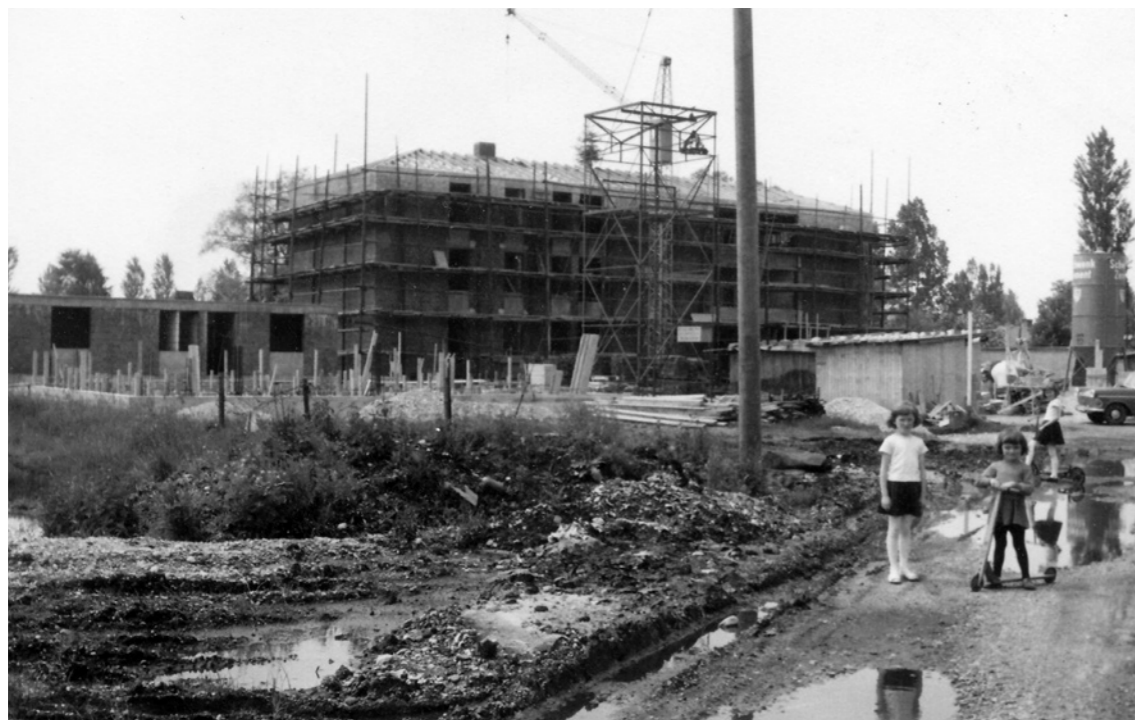
Der Dachstuhl auf dem fertigen Rohbau mit Richtbaum, links im Bild nimmt das Feuerwehr-Gerätehaus (heute Stadtbibliothek) bereits Konturen an.
