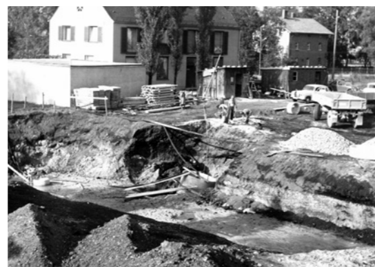
Die Rathaus-Baugrube vor dem benachbarten Postgebäude (später „Sabrena“-Haus und heute Montessori-Kindergarten). Hinten rechts ist das ehemalige Arbeiterhaus der Hausmüll-Fabrik zu erkennen.
